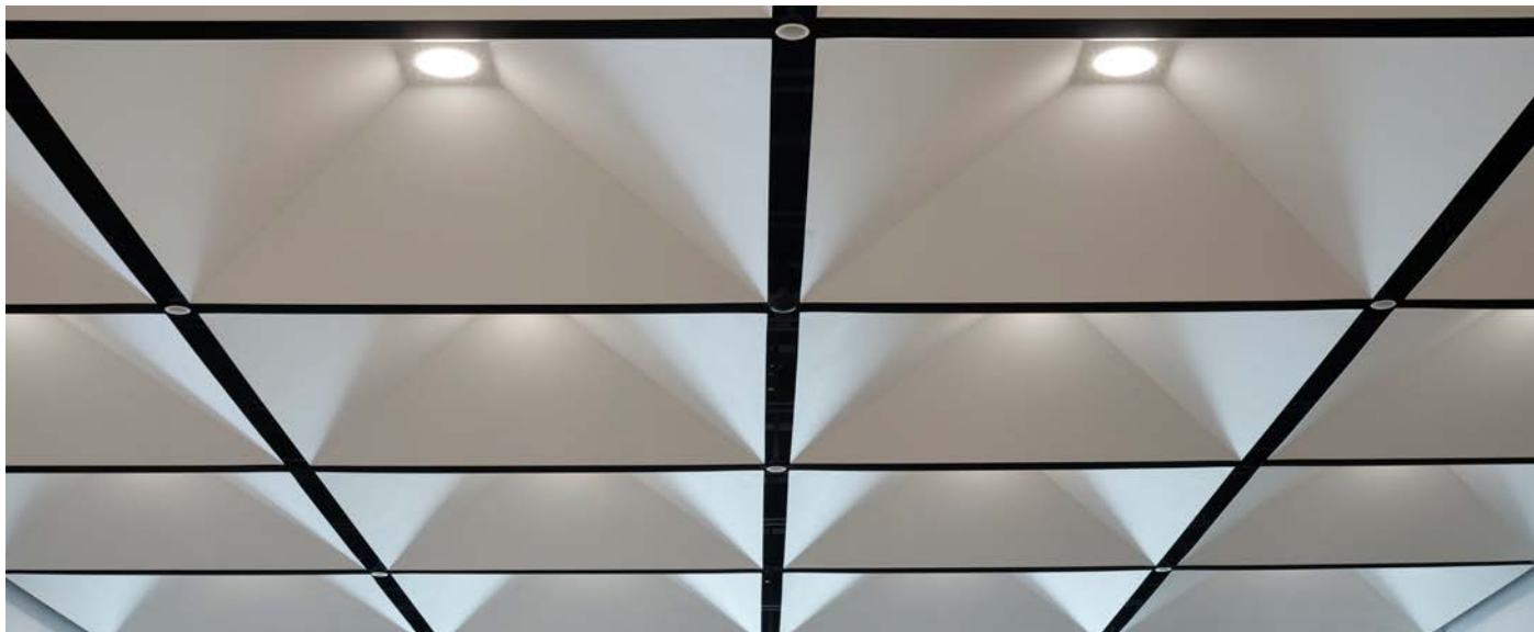
Abb.: Die Trichter-Leuchten aus Aluminiumblech unterstützen die geradlinige Architektur des Gebäudes, sie sind innen in Mattweiß und außen in Mattschwarz ausgeführt und liefern eine maximale Lichtleistung.
