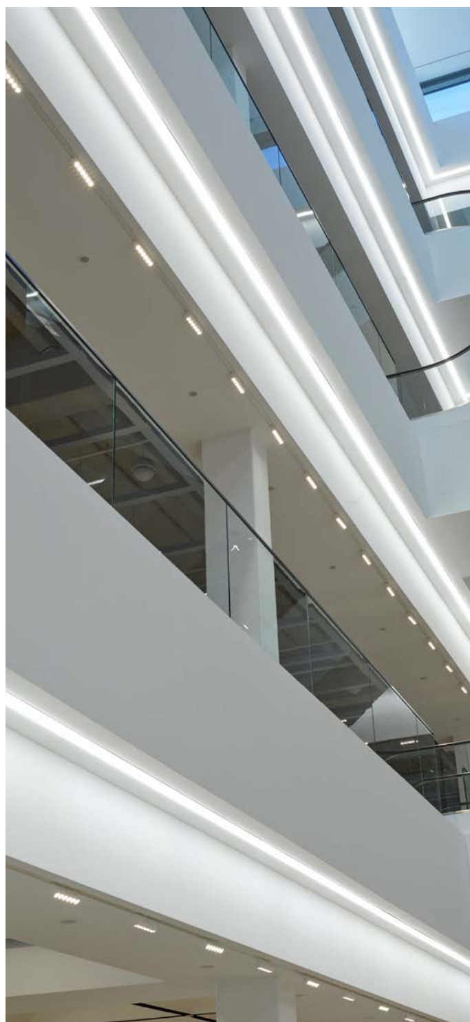
Abb.: Die Verkehrswege der einzelnen Etagen werden ebenfalls durch das modulare LED-Beleuchtungssystem erhellt. Die High Power LED-Module arbeiten in Saarbrücken nicht mit Reflektoren, sondern mit Kollimatoroptiken.
