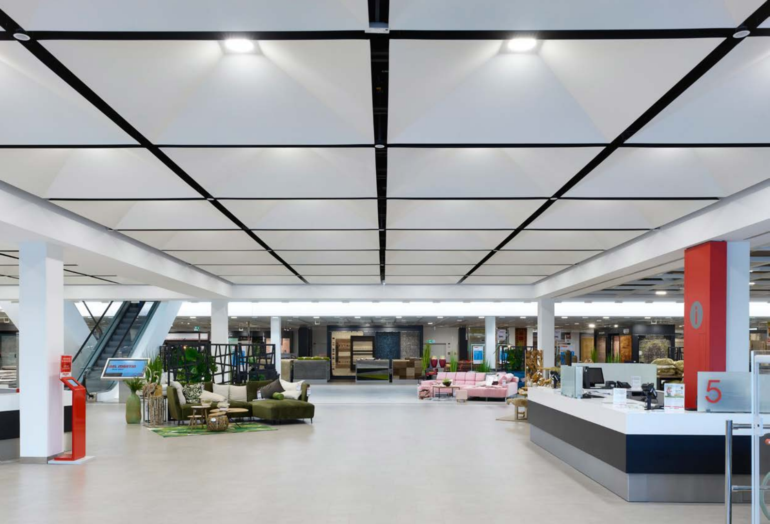
Abb.: Im Eingangsbereich herrscht eine angenehme Atmosphäre, ohne einen wahrnehmbaren Wechsel von drinnen nach draußen und umgekehrt. Die trichterförmigen Sonderleuchten führen den Tageslichthimmel nach innen weiter.
