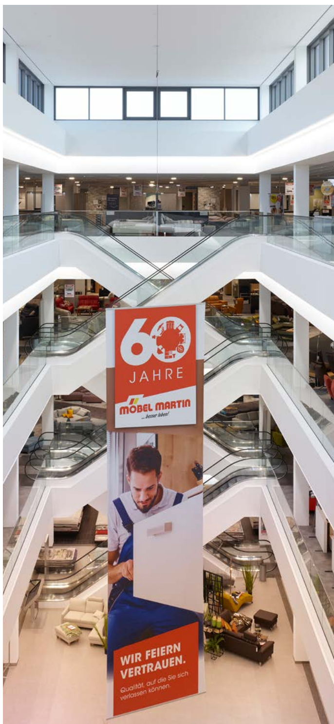
Abb.: Über den verglasten Obergaden gelangt Tageslicht in das Atrium. Im horizontalen Vorsprung der jeweiligen Gebäudeebenen sind 8 cm breite LED-Lichtbänder integriert, deren Blauanteil nach oben hin leicht zunimmt.
