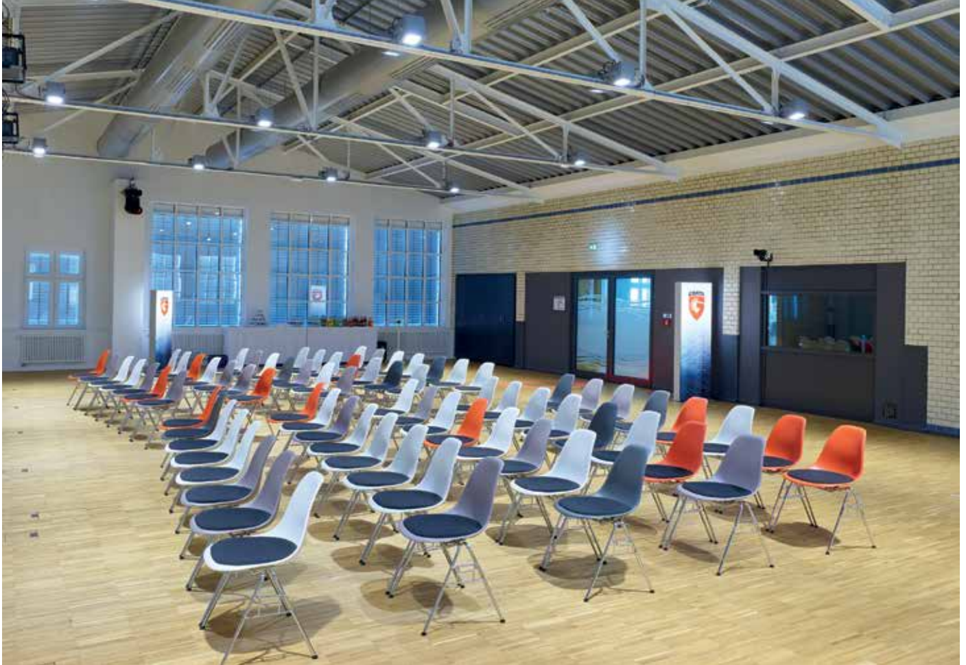
Abb.: Die Eventhalle wird für Schulungen und Veranstaltungen genutzt. In die bestehende Architektur wurden würfelförmige Außenleuchten integriert, die sowohl Allgemeinbeleuchtung als auch Showlicht liefern.
