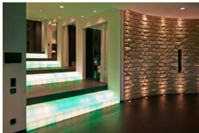
Abb.: Die leuchtende Treppe ist eine Spezialanfertigung. Sie besteht aus Blockglasstufen, in die Flächen-LED-Leuchten, so genannte Planes, eingebaut sind.
