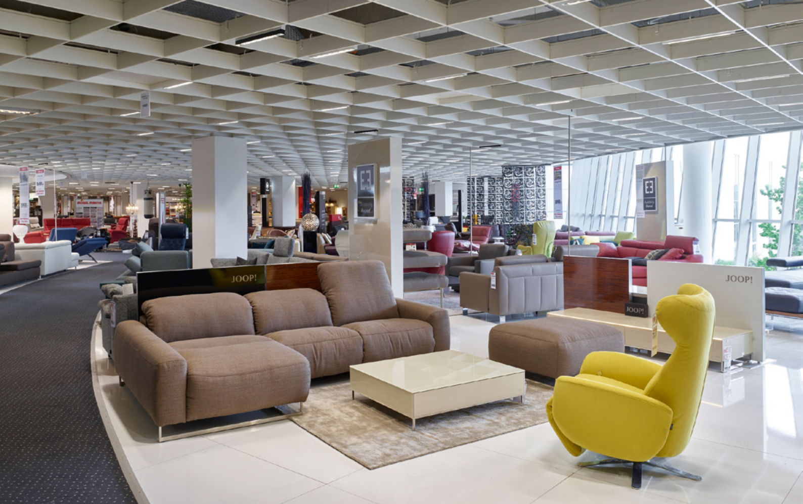
Abb.: Die Beleuchtung im Innenraum mit Tunable White LEDs orientiert sich nach dem Tageslicht außerhalb des Gebäudes. Ein Sensor übermittelt die Daten auf das System, das das Licht innerhalb eines Spektrums von 3000 bis 5000 K mit einer Mischung aus warmweißem und kaltweißem Licht über den Tag verteilt anpasst.
