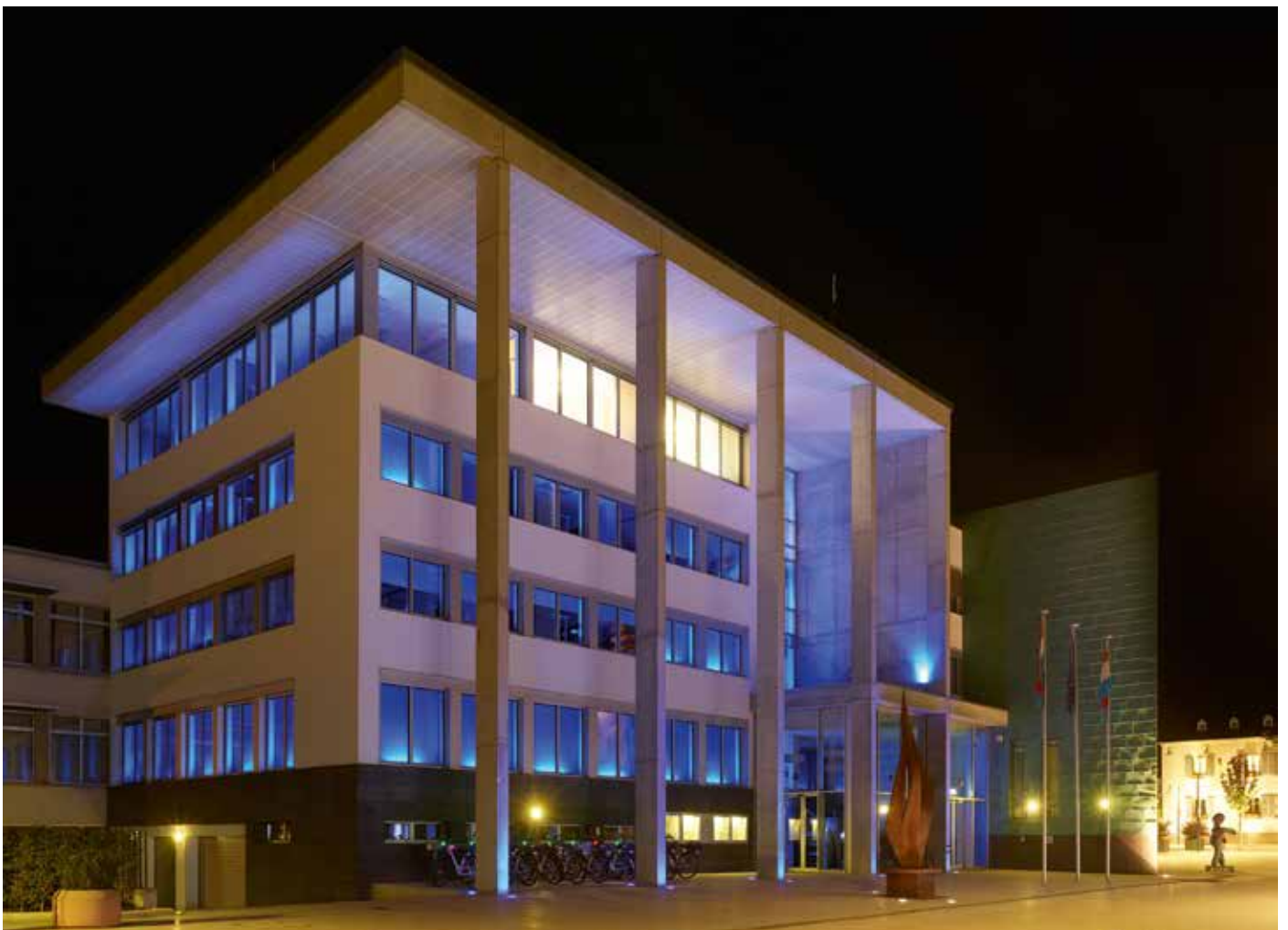
Abb.: Für die homogene Beleuchtung des Rathauses wurde in Absprache mit dem Architekten geklärt, ob überall LED-Lichtlinien an den Fenstern eingebaut werden können. Die Betonstützen sind in das Konzept integriert.
