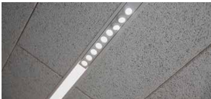
Abb.: Das Profilsystem Instalighting »NoLimit« fügt sich dezent in die Deckenstruktur ein. Darin lassen sich unterschiedliche Leuchteneinsätze frei kombinieren, etwa in Form von Lichtlinien oder Einbaustrahlern.
