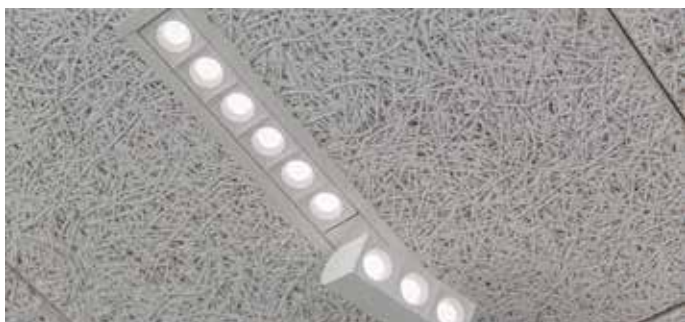
Abb.: Einbauleuchten und High Power-Strahler »NoLimit« erzeugen eine homogene Lichtmischung mit Tunable White zwischen 2700 und 5000 K. Die Strahler sind stufenlos dreh- und schwenkbar und im Profil frei zu positionieren.
